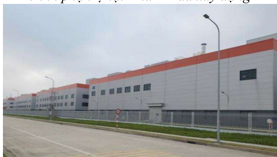
Hiện trạng nhà xưởng – đã xây dựng
