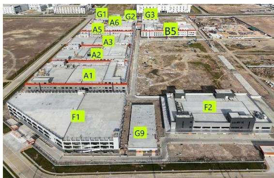
Các nhà xưởng A1,2,3,5,6,B5 và 1 số công trình phụ trợ tại Khu 1 – đã xây dựng
