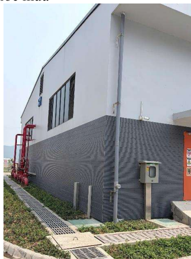
Hình 3. 2. Hệ thống thu gom, thoát nước mưa của dự án
