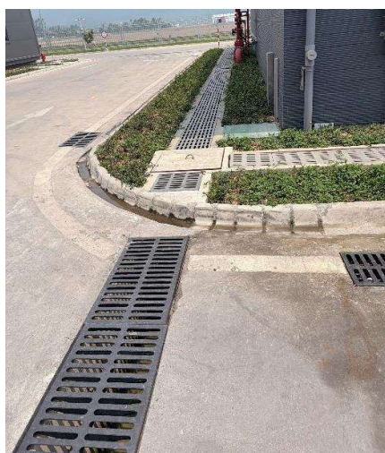
Hình 3. 2. Hệ thống thu gom, thoát nước mưa của dự án
