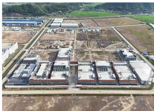
Các công trình còn lại tại Khu 1 – đang triển khai xây dựng
